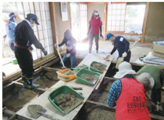
【プロボノ団体と連携した床下の土砂撤去】
