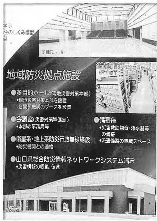
山口県大島防災センター
