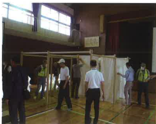
紙管間仕切りシステム組み立て作業
