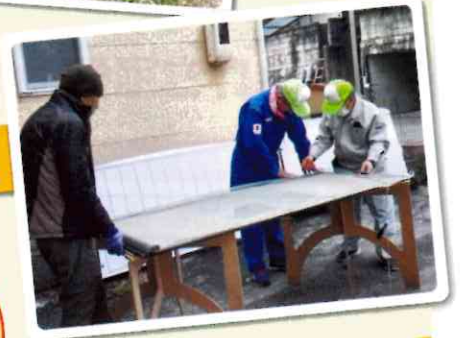
網戸、障子の張替え作業
