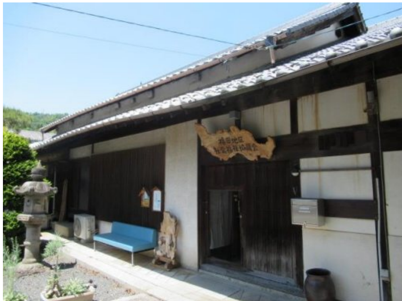
▲以前より候補として考えていた古民家。建物のオーナーに何度も交渉し利用できることになった。
