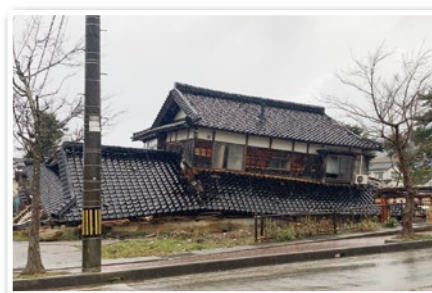
▲被災現場の様子
