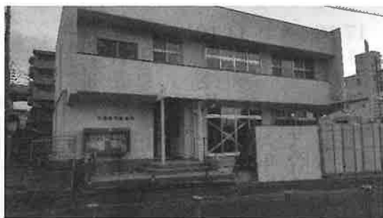
矢賀新町集会所の耐震工事
