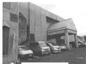
改修工事写真
