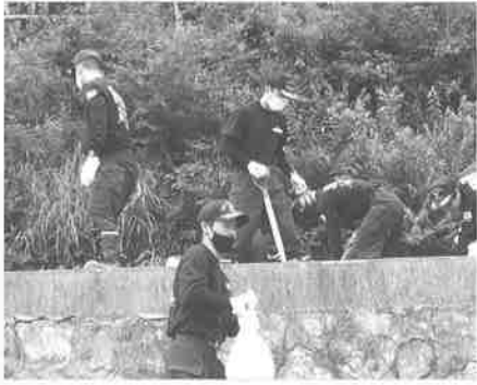
消防学校の学生ボランティアによる土砂の撤去作業
