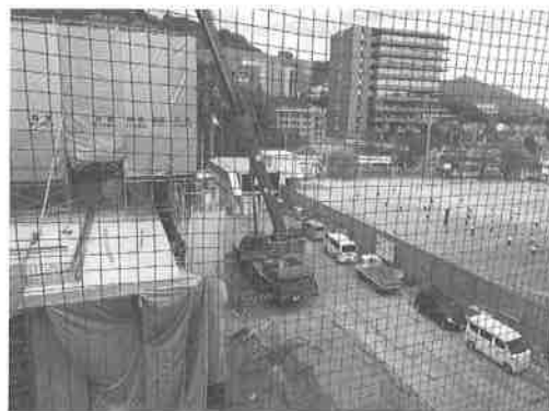
体育館の新設工事
