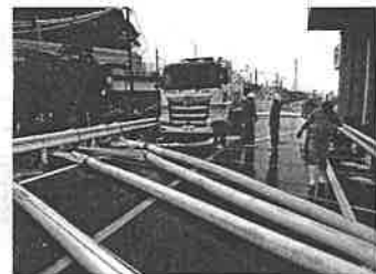
事前に準備されていた排水ポンプ車 懸命の排水。矢口川水門の増水で、配備したポンプ車のホースが一斉排水。
