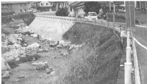
2020/1 復興 工事期間中は通行止め、中野方面に迂回
