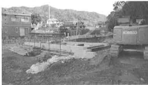
2021/5 開通予定 この橋を県道のバイパスにして随木屋橋北を工事する予定
