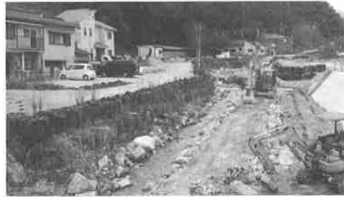
右護岸 2021/9 完成予定 左護岸・道路計画未定
