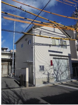
完成した消防車庫
