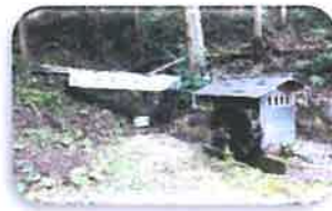
第2水車 H26年5月完成
