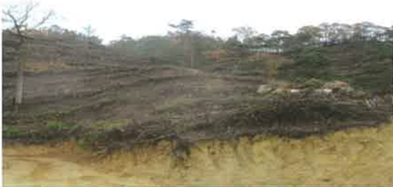
地拵えされた林地と新しくつけられた作業道
