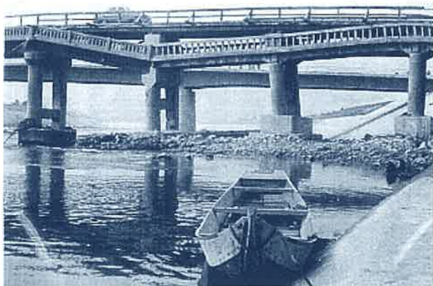
写真は崩壊した当時の「深川橋」の様子です。上部に見えるのは復旧工事に伴う仮橋です。水害から2年後の昭和43年には現在の「深川橋」が完成し渡り初め式が盛大に営まれました。
