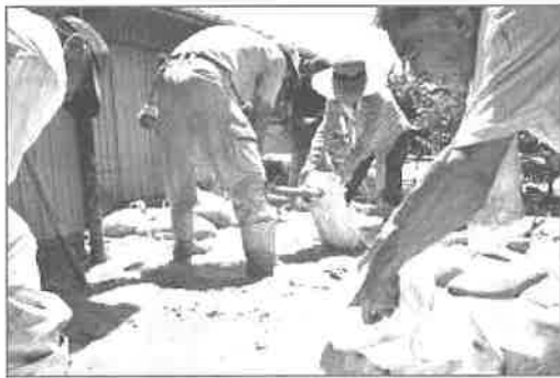
酷暑の中の「土のう詰め」
