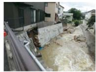
護岸のコンクリート壁が崩落
