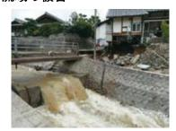
土石流による住宅と基礎の損壊
