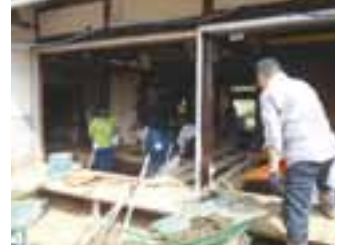
床下の泥出し作業の様子
