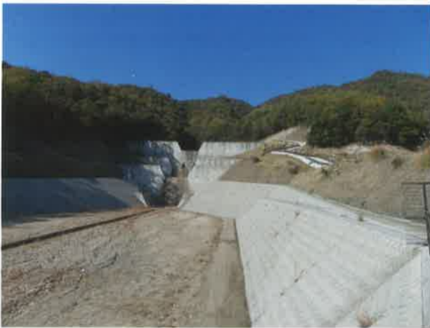
303溪流砂防堰堤と広大な土石流堆積工
