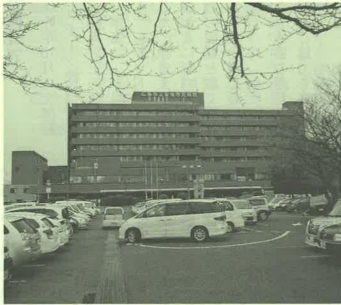
跡地利用のため取り壊される安佐市民病院南館と駐車場
