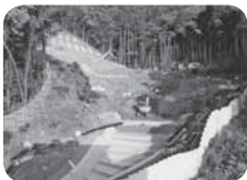
写真は市営住宅25号館東側砂防ダム建設現場
